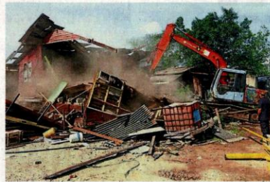
执法人员展开拆除行动，所有违章建筑皆夷为平地。
