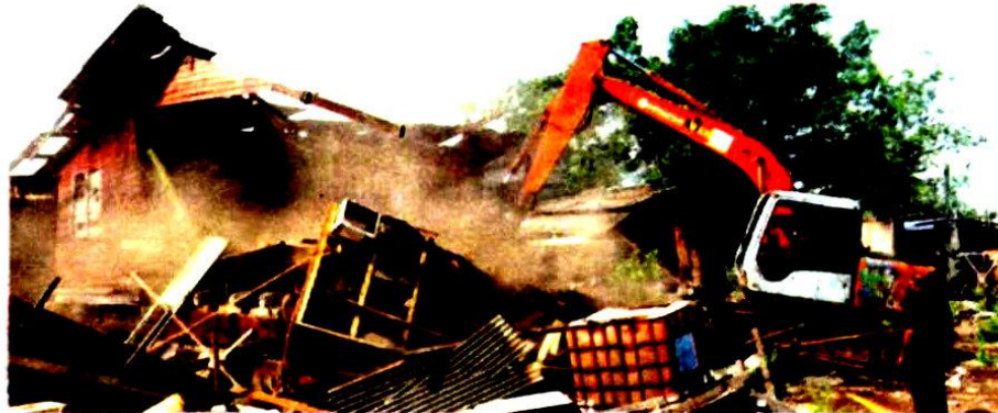
Kerja-kerja merobohkan kilang kayu dan papan, stor penyimpanan serta kediaman pekerja dilakukan dalam operasi di Jalan Jeti, Pelabuhan Klang pada Khamis.
