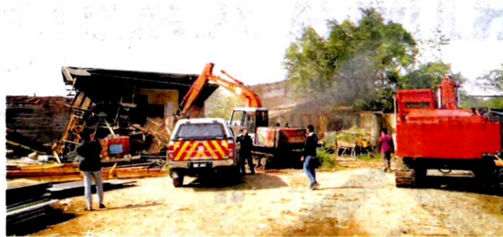
SEBUAH kilang papan haram dirobohkan pihak berkuasa di Jalan Jeti Pelabuhan Klang, Klang semalam.
